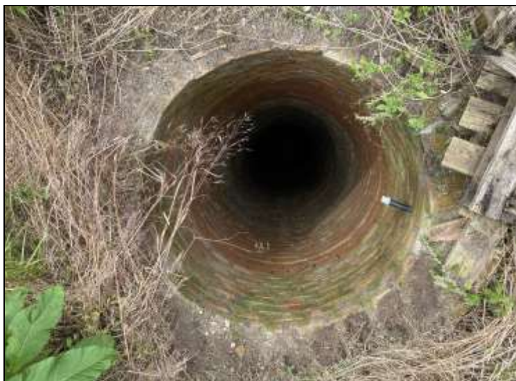
Figura 5: ripresa della colonna interna del pozzo presente nel cortile di palazzo Freri - Cappellazzi, profondità 7,60 m da p.c.; all'ispezione del 07/06/2021 il pozzo è risultato completamente asciutto
