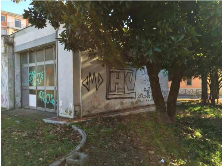
Nelle strutture verticali si evidenziano notevoli fessurazioni e crepe anche strutturali, nonché la comparsa di muffa e patina vegetativa derivante dallo stato di abbandono dell'immobile. Sono presenti inoltre marcati fenomeni di umidità ascendente e discendente dovuti al degrado delle opere di impermeabilizzazione.
