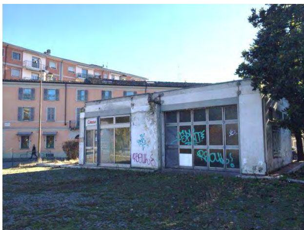
Immagine n. 2 – Fabbricato esistente da demolire
