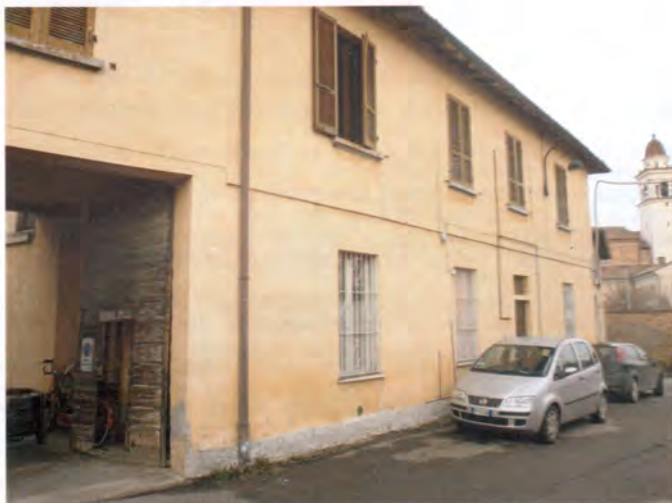
Edificio da ristrutturare – via dell'Assedio.
