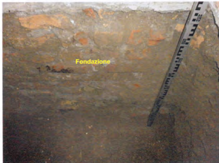
Fig. 7 – Sondaggio T1, sono evidenti fondazioni perimetrali in buone condizioni.
