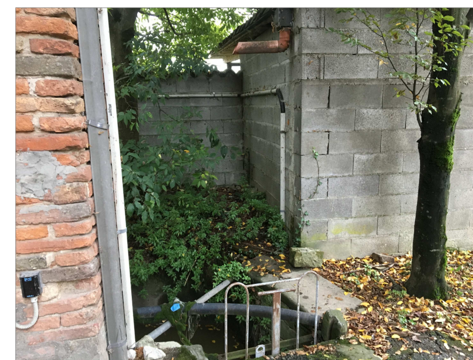
Vista fabbricati oggetto di intervento
