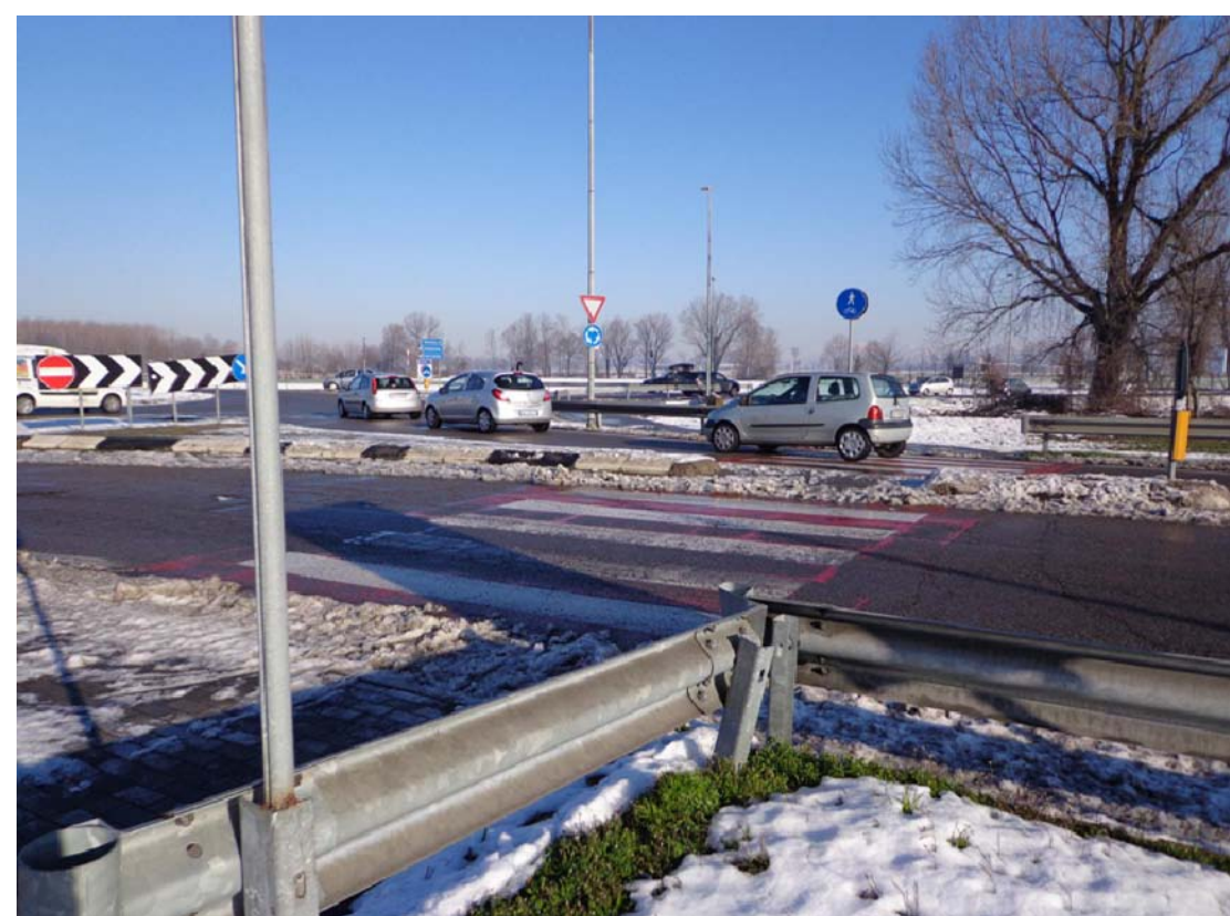
DETTAGLIO ATRAVERSAMENTO A RASO CILOPEDONABILI
