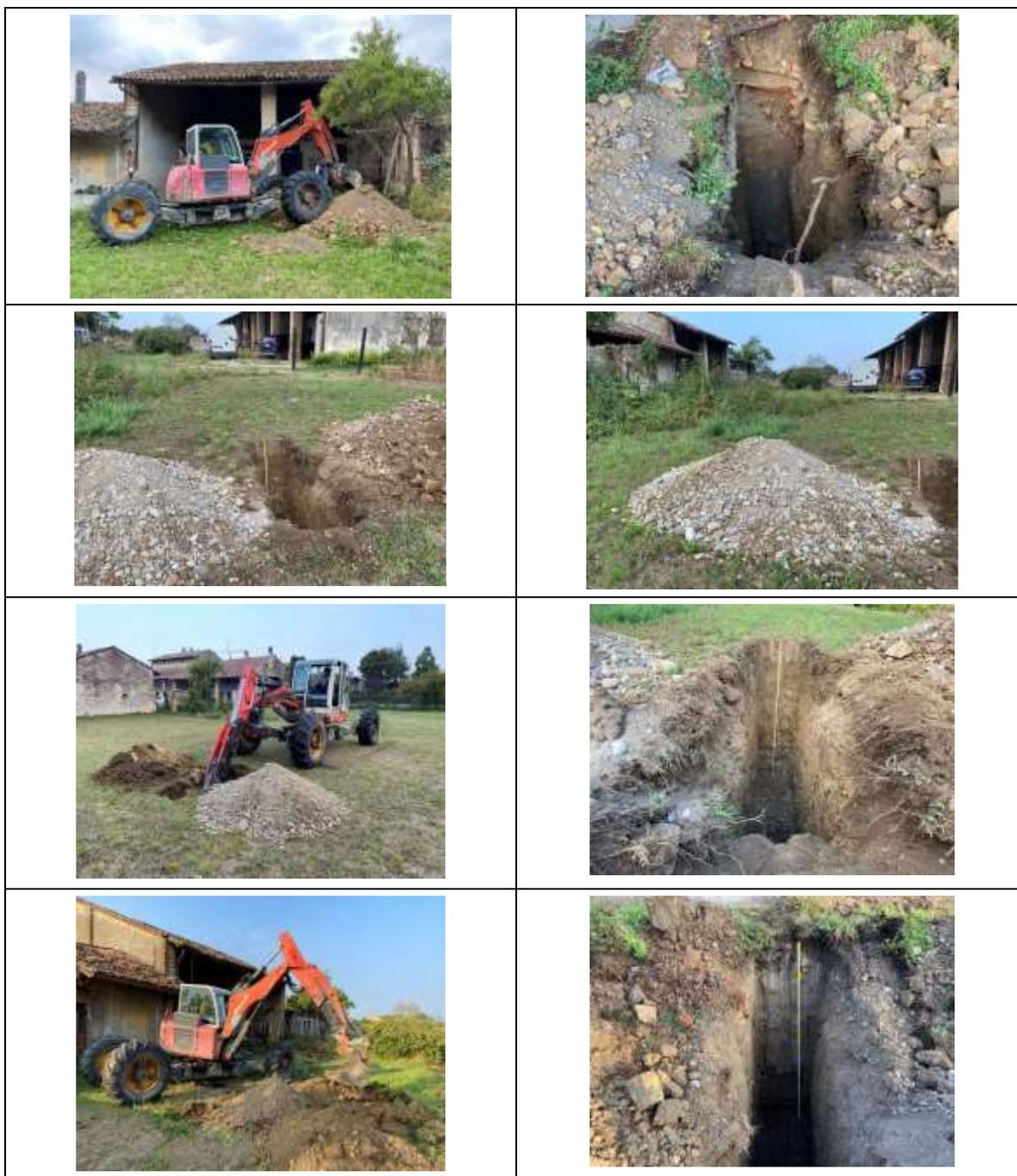
**Figura 7:** esecuzione e visione dell'esecuzione dei fronti di scavo delle trincee esplorative da s1 (in alto) a s4 (in basso) visionate nel sito di Crema (CR) il giorno 23/09/2021. Risulta molto ben riconoscibile lo strato di riporto e la coltre di copertura sommitale limo-sabbiosa e argillosa di spessore tra 1 e 2 m, seguita dalle sabbie e ghiaie più profonde
