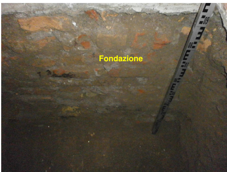
Figura 9 – Sondaggio T1, sono evidenti fondazioni perimetrali in buone condizioni.
