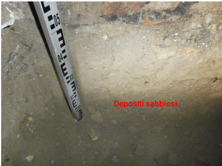
Figura 11 – Sondaggio T3. Sono evidenti i depositi sabbiosi al di sotto del magrone e delle fondazioni di muratura.
