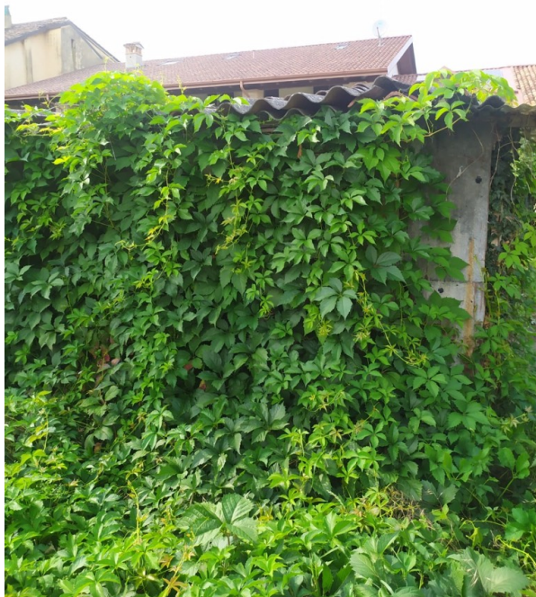
Prospetto sud edificio esistente
