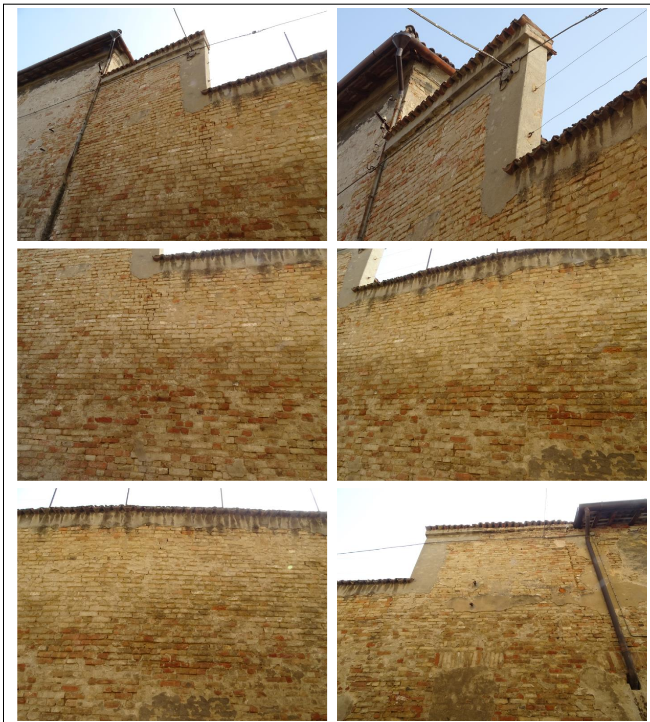
Figura 3 – Stato di conservazione della muratura in mattoni pieni (lato esterno)
