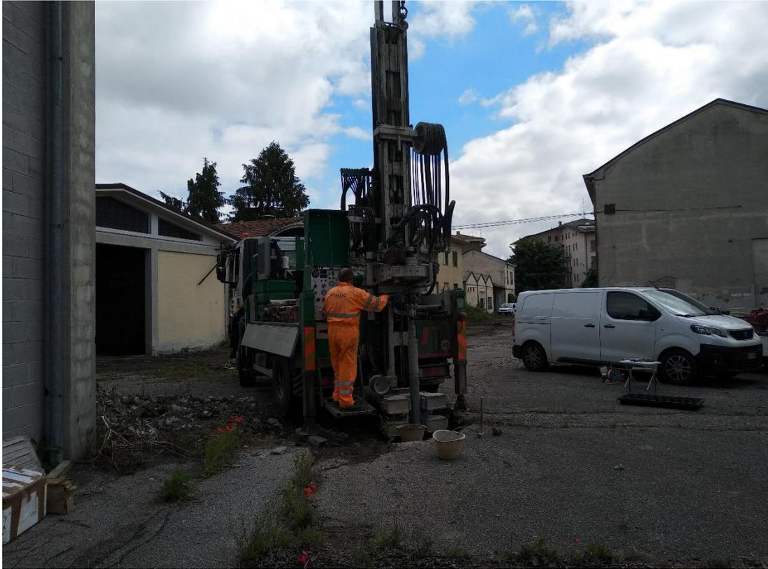
*Figura 7: esecuzione sondaggio S4*
