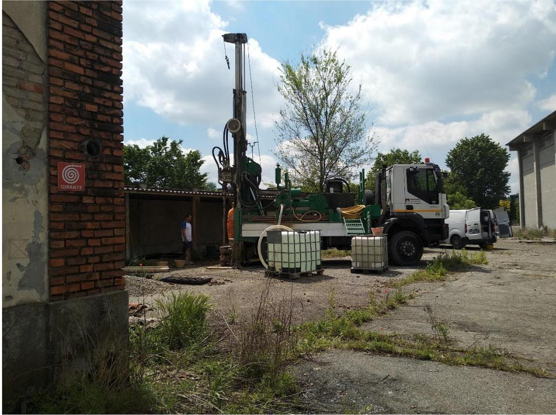
*Figura 9: esecuzione sondaggio S5*
