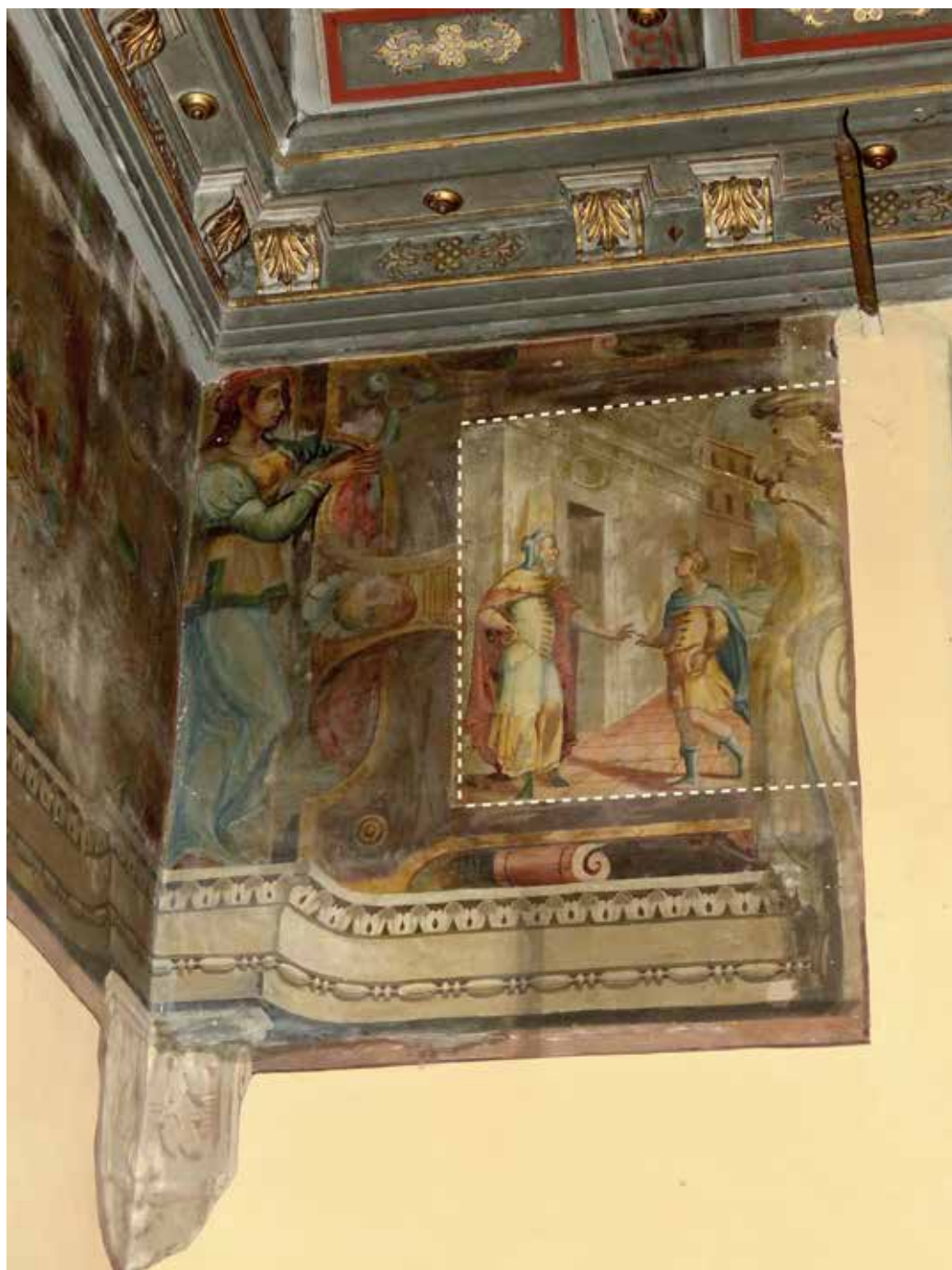
Prova di pulitura eseguita su una porzione dell'affresco della sala del figliol prodigo
