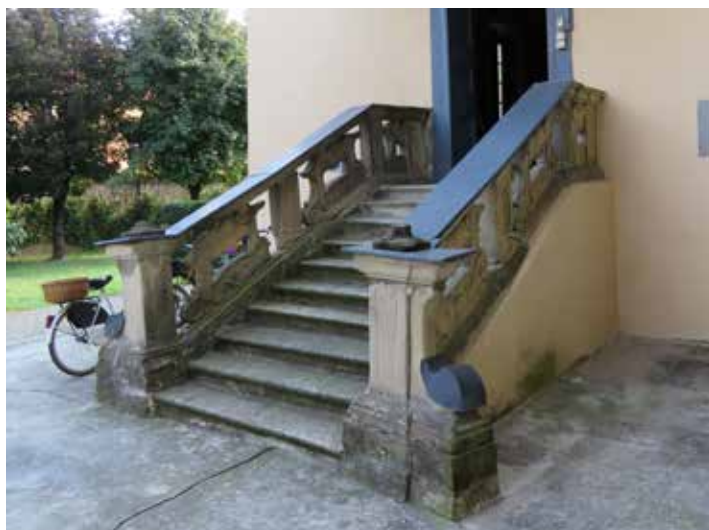
La scala di ingresso al Salone d'Onore prima e dopo l'intervento
