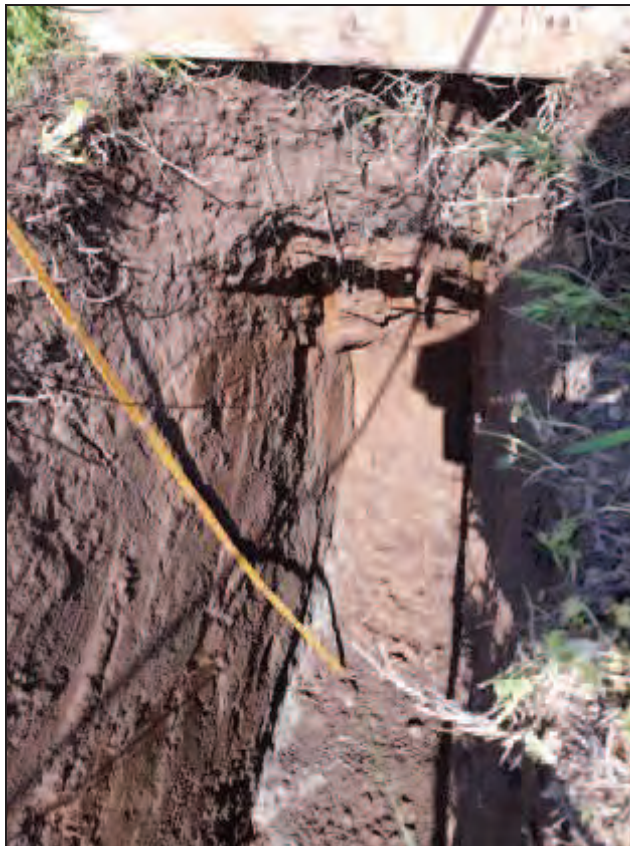
Fig. 5: trincea esplorativa (scavo) nel sito di Le Tecchie, comune di Crema (profondità massima m 2)
