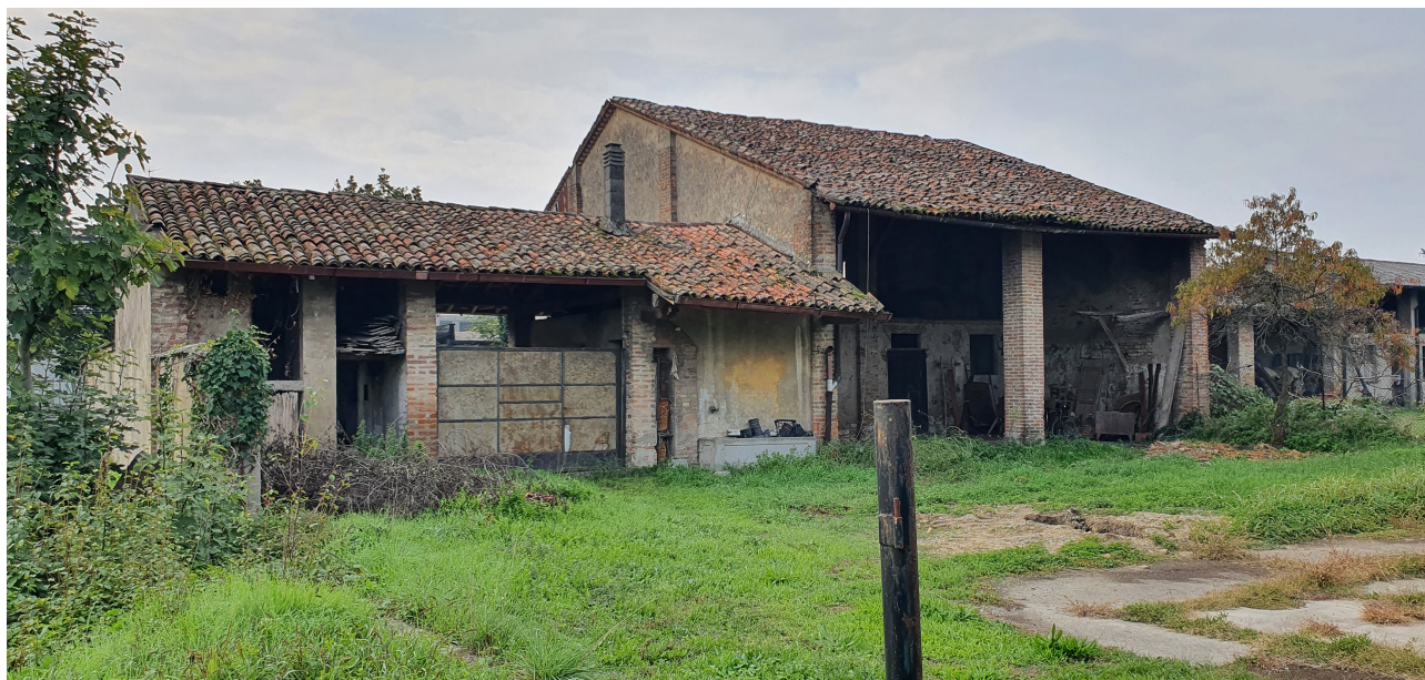
EDIFICIO B - ATTUALE
