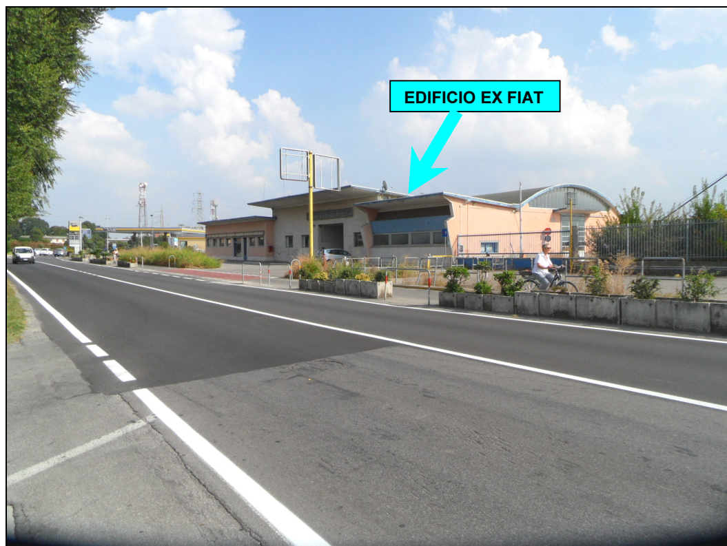
foto 1: vista dell'attuale stabile "ex Fiat" e dell'area di progetto vista da viale Europa da Nord-Ovest.
